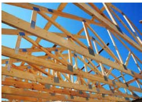
2. ábra | Egyedi rácsos tetőszerkezet (Illusztráció)
