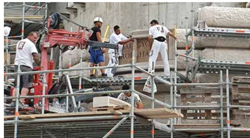
3. kép | Földszinti mészkő burkolat rögzítése / Füleky Zsolt felvétele
