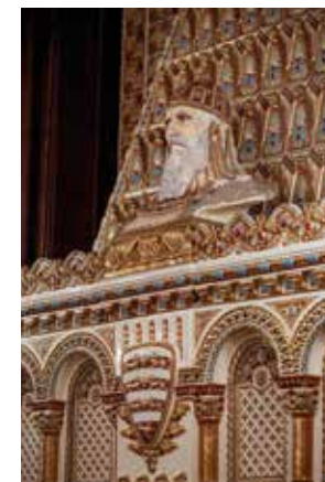
5. kép | A kandalló elkészítése a szükséges kísérletekkel egy évig tartott. Egyes részei nyolc-tíz festési és égetési fázison is átesetek az aranyozási munkák előtt / Várkapitányság, fotó: Kárász Karolina
