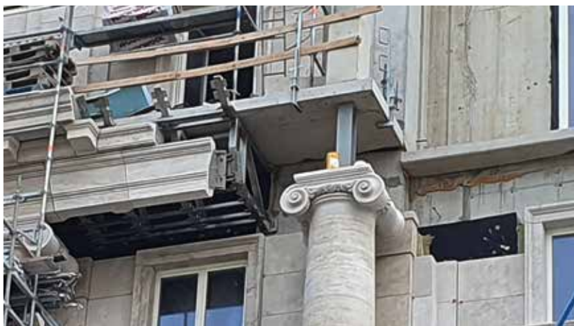
5. kép | Az előre faragott süttői mészkő elemek rögzítése / Füleky Zsolt felvétele
